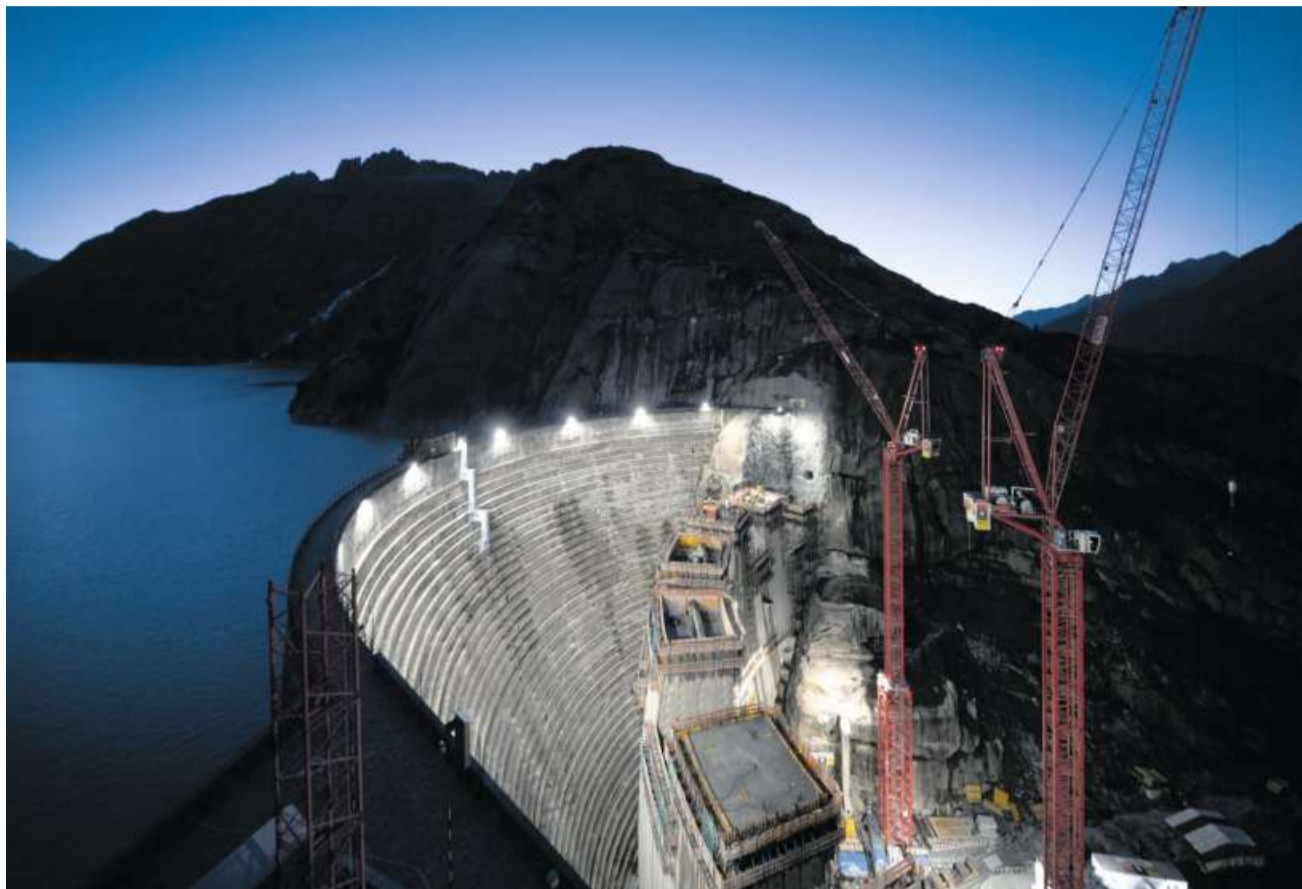
Die Kraftwerke Oberhasli ersetzen die bestehende Staumauer am Grimsel durch eine neue.
